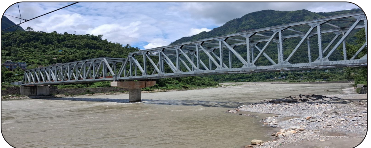
निर्माणधीन दमौली भापुटार पुल लम्बाई १५६ मिटर तनहुँ
