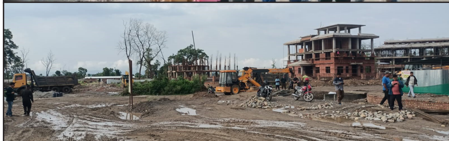
नवलपूर जिल्लाको निर्माणाधीन नमुना सदरमुकामको अवलोकन तथा निरीक्षण
